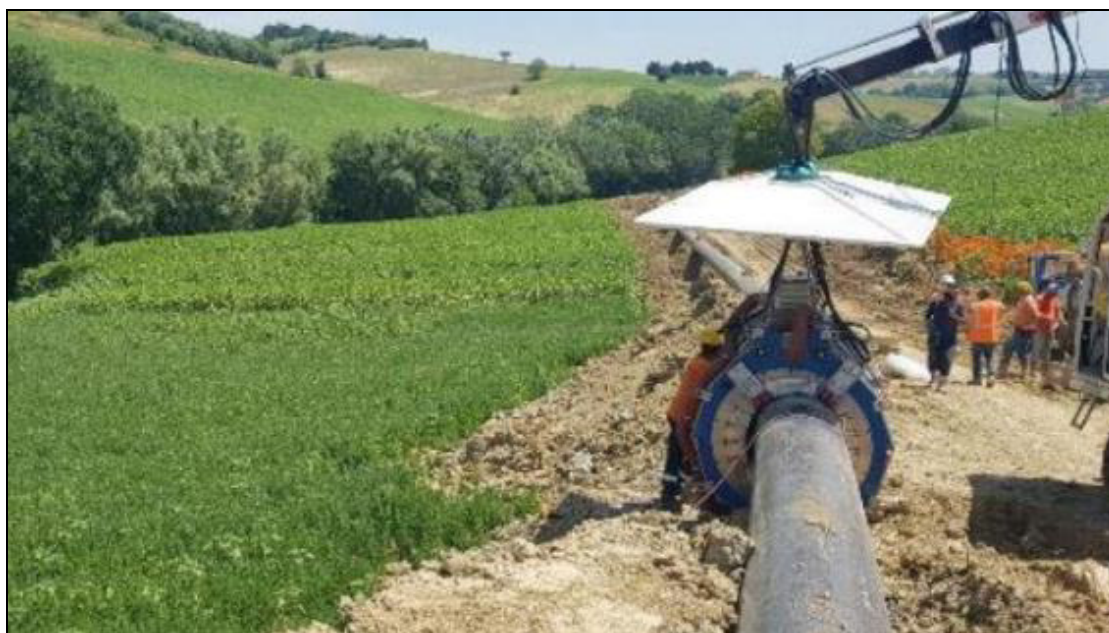
Foto 3.2.1/E Esempio di saldatura automatica
