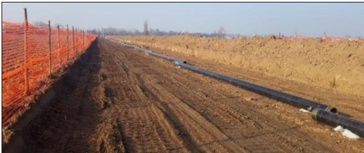
Foto 3.2.1/C Sfilamento delle tubazioni di linea
