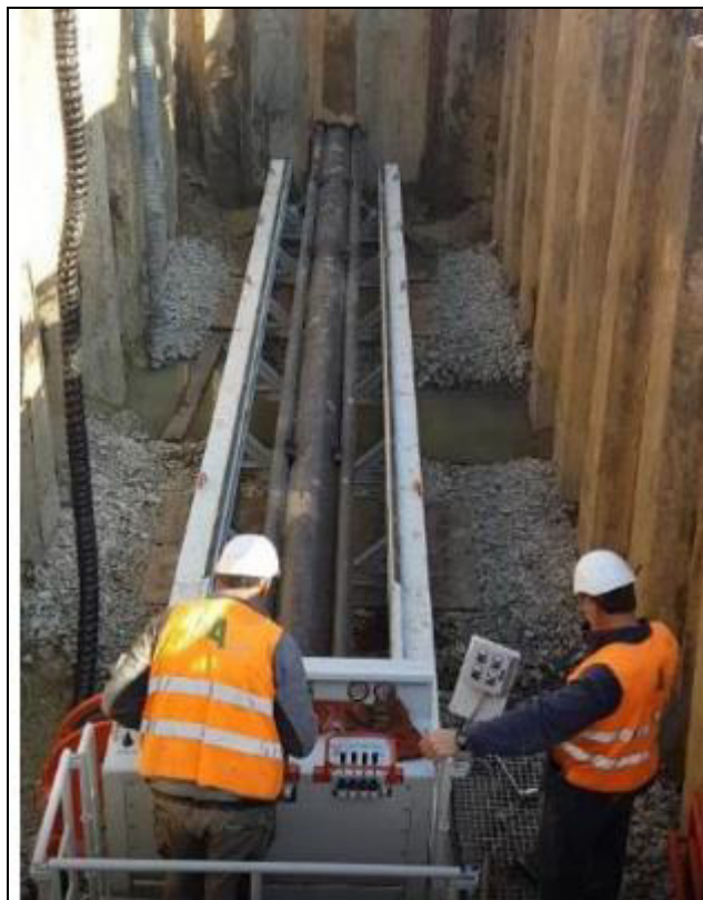
Foto 3.2.1/L Trivellazione con spingitubo
