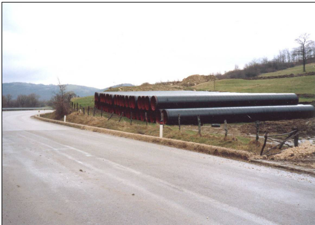
Foto 3.2.1/A Esempio di piazzola di accatastamento tubazioni
