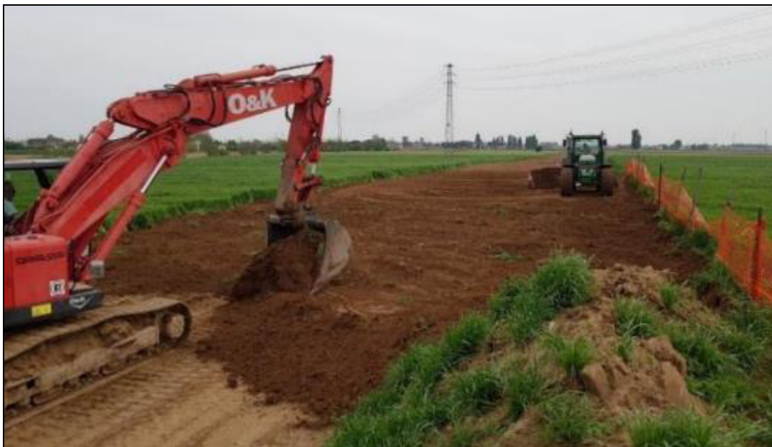
Foto 3.2.1/K Distribuzione dello strato fertile superficiale
