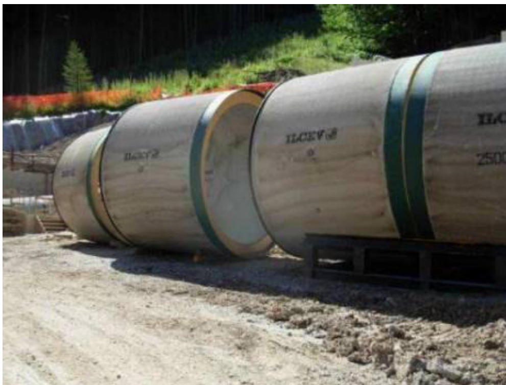
Foto 3.2.2/E Stoccaggio tubi in c.a.
