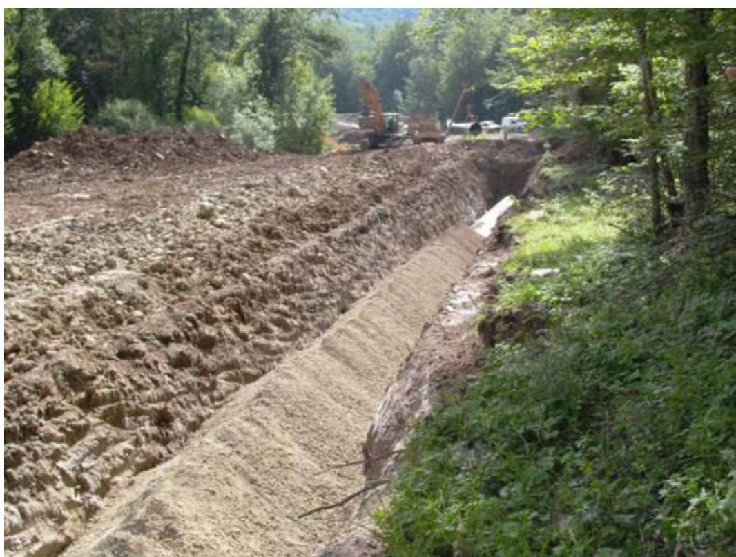
Foto 3.2.1/J Rinterro della condotta
