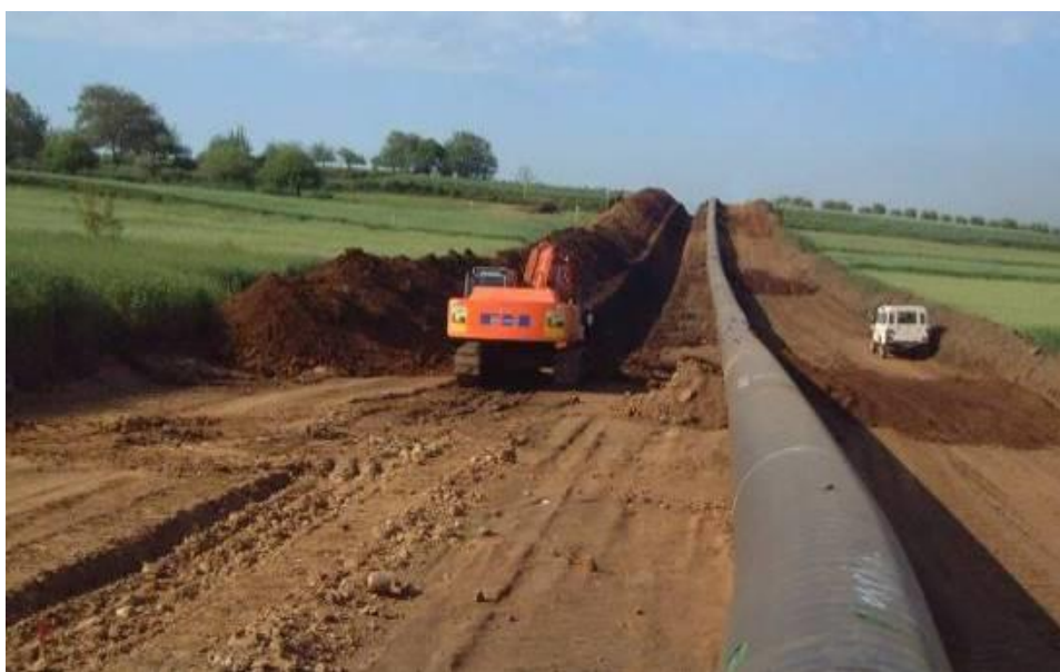
Figura 2.4 - Scavo della trincea
