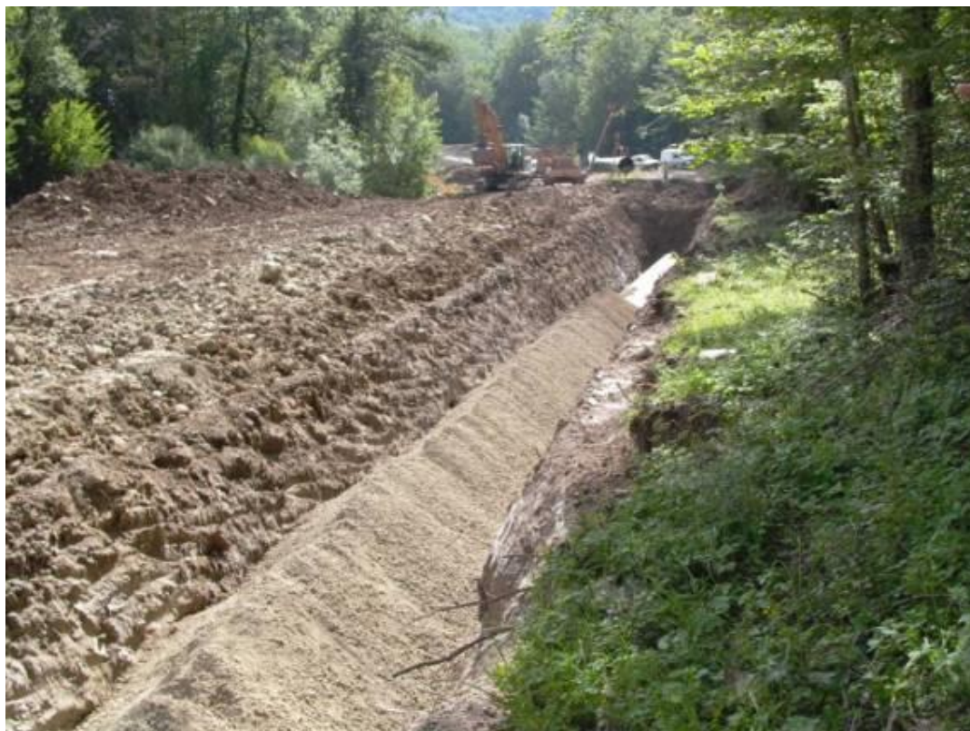
Figura 2.6 - Rinterro della condotta
