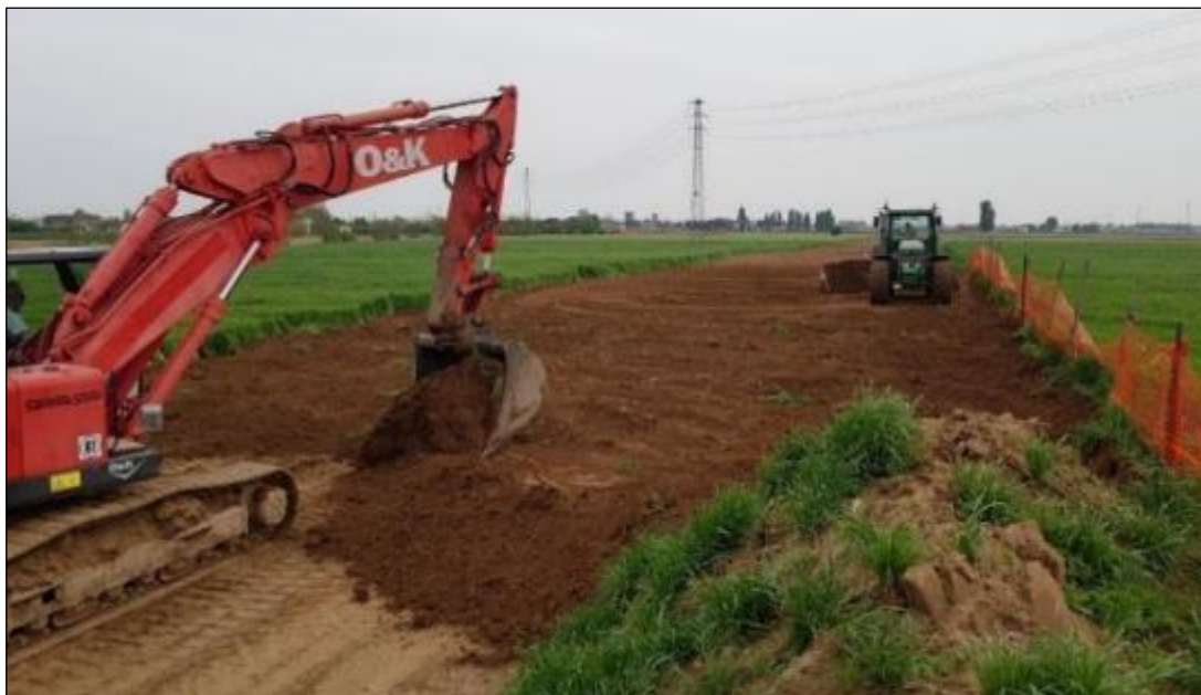
Figura 2.7 - Ridistribuzione dello strato humico
