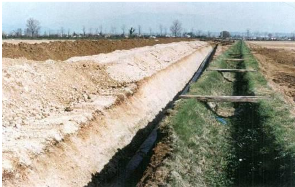
Figura 2.5 - Tratto di condotta posata, si noti l'accantonamento dello strato humico separato dal materiale di scavo della trincea
