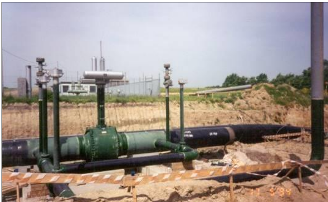
Figura 2.8 - Esempio di punto di intercettazione di linea (PIL)
