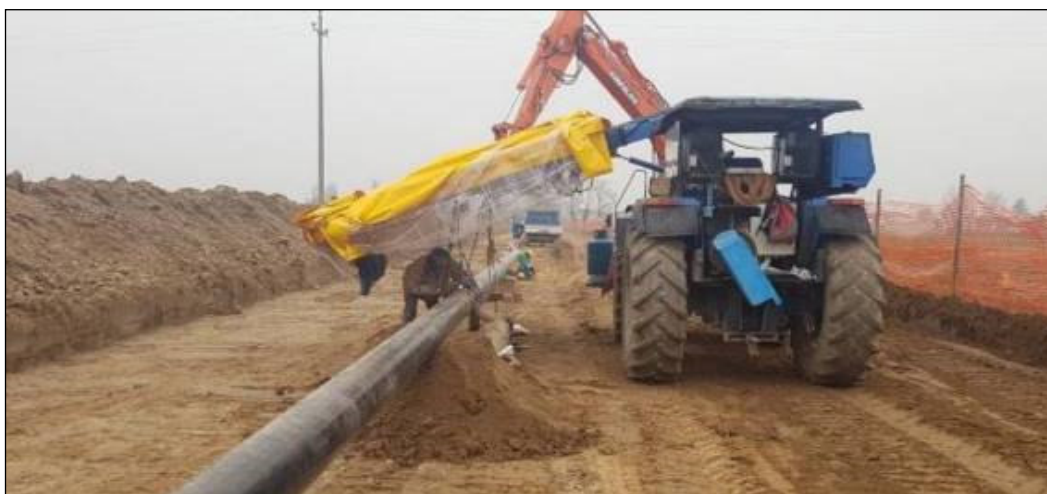
Foto 4.2.4/A - Esempio di saldatura manuale
