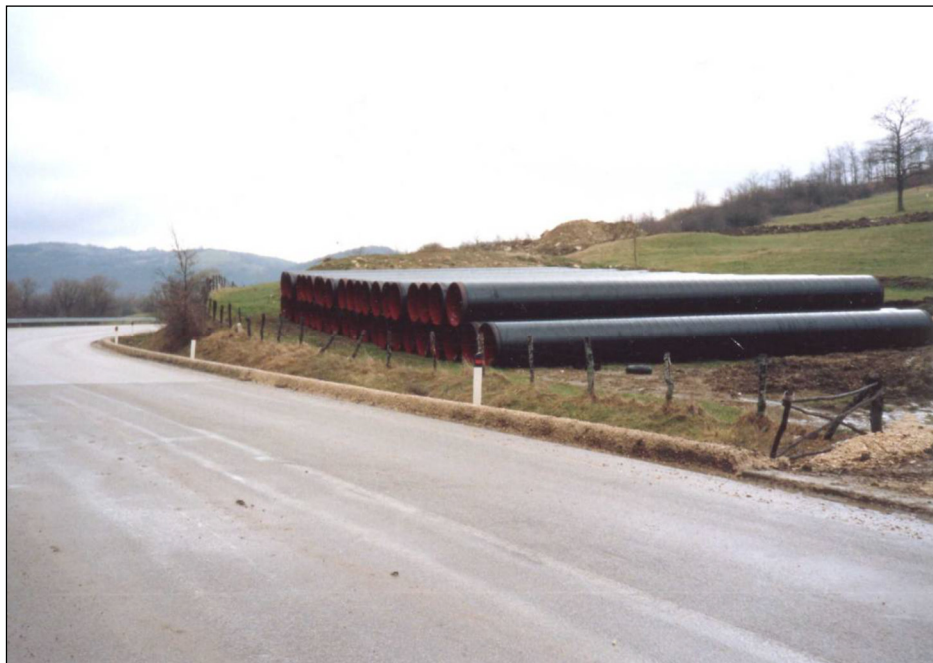
Foto 4.2.1/A – Esempio di piazzola di accatastamento tubazioni
