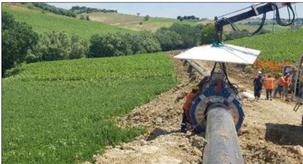
Foto 4.2.4/B - Esempio di saldatura automatica
