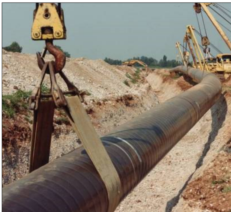
Foto 4.2.7/A - Posa della condotta (esempio di condotta con diametro superiore alla linea in progetto)
