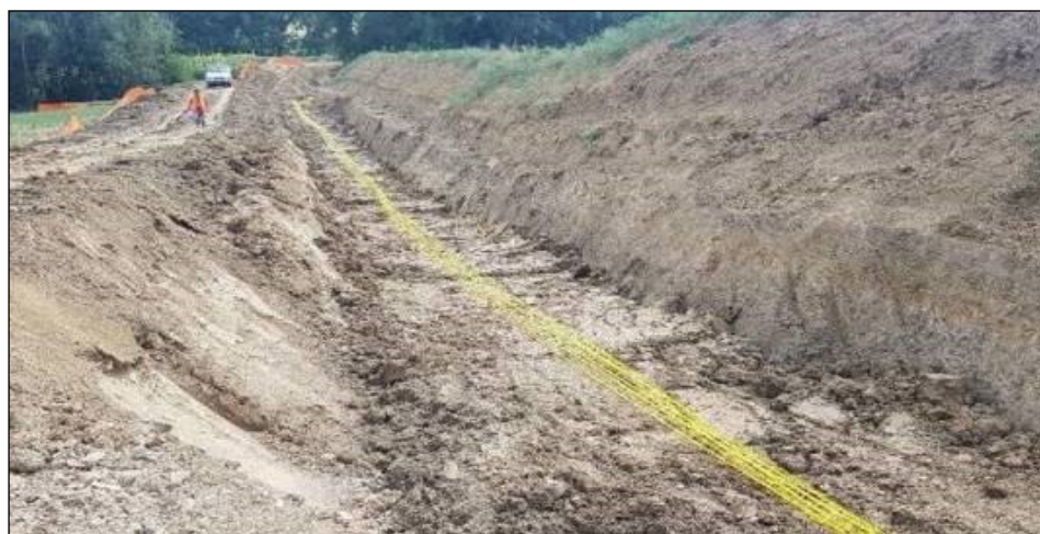
Foto 4.2.8/A - Rinterro della condotta
