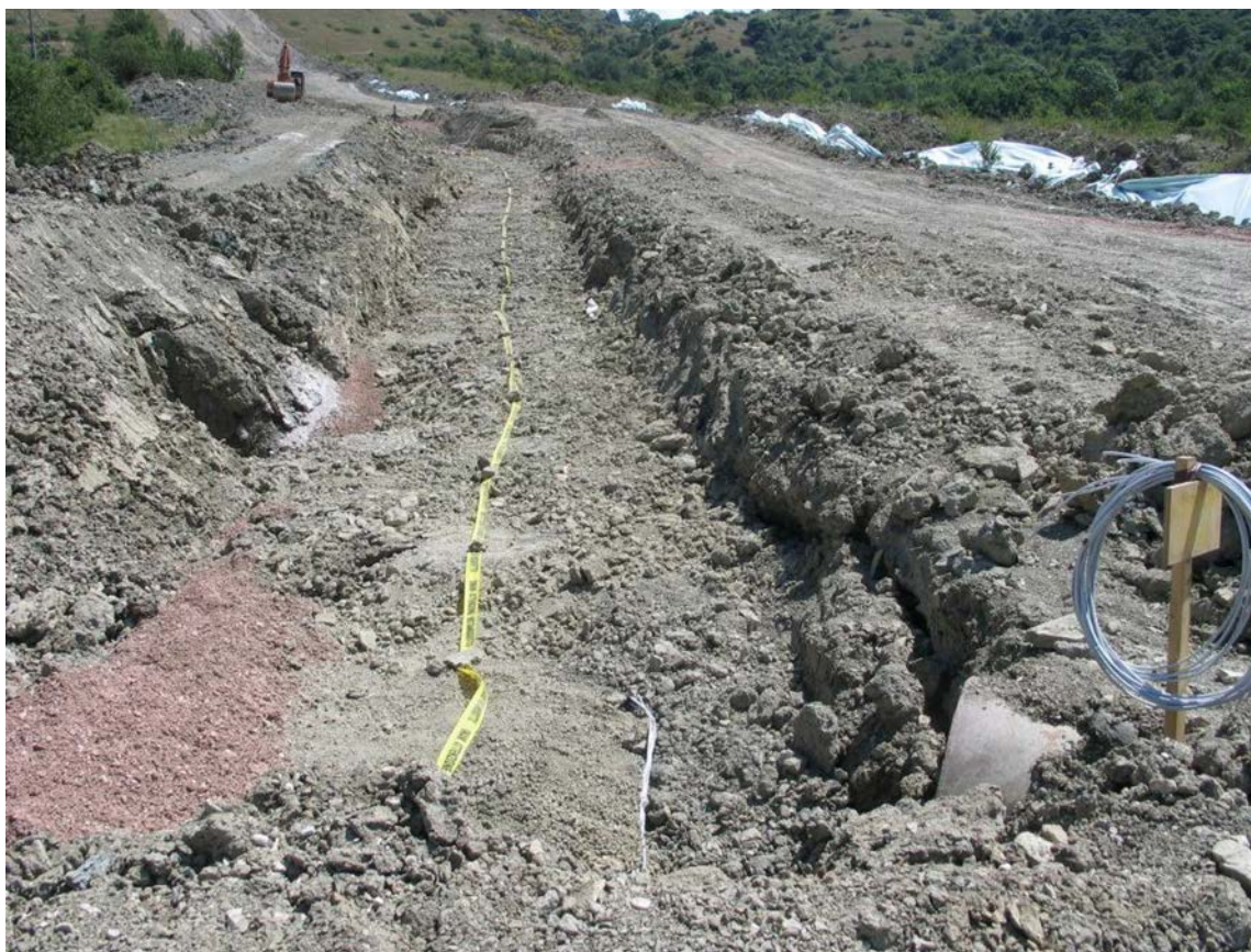
Foto 7.8/A - Rinterro della condotta
