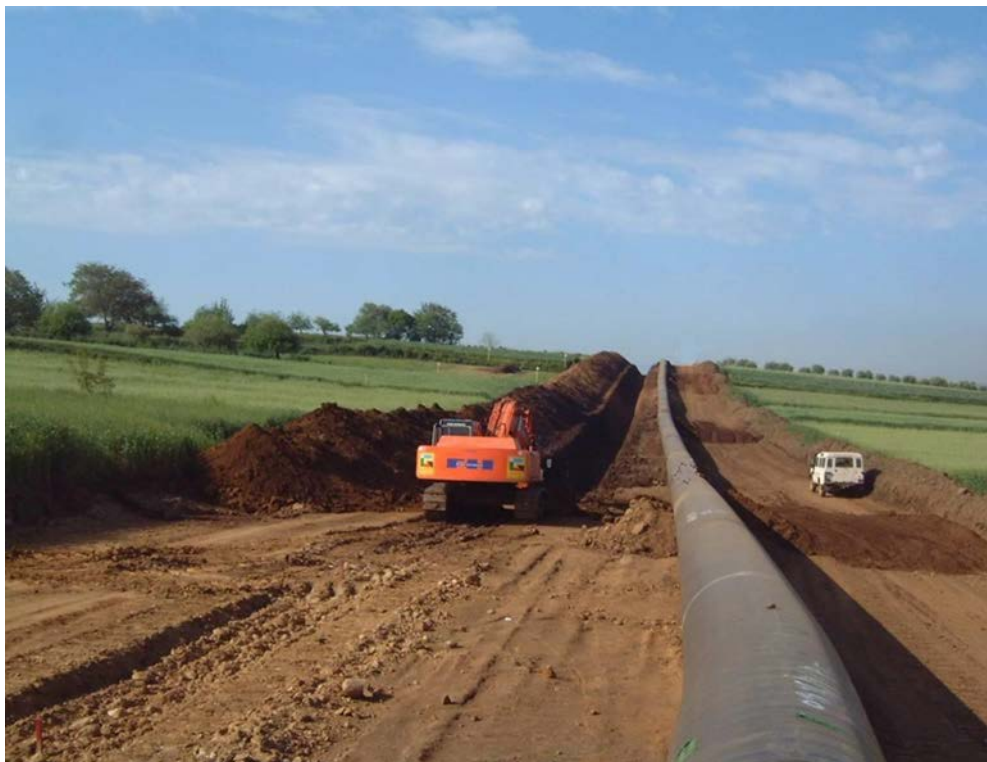
Foto 7.5/A - Scavo della trincea in area agricola.
