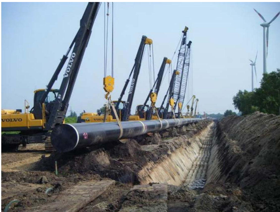
Foto 7.7/A - Posa della condotta con side-boom. In aree boscate l'operazione di posa sarà eseguita mediante l'impiego di escavatori
