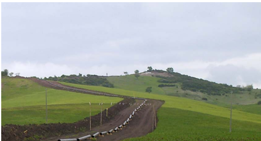
Foto 7.2/A - Sfilamento tubazioni in area agricola
