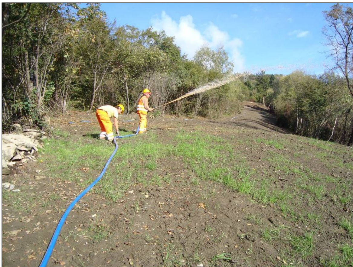
Foto 9.3/A - Distribuzione del miscuglio di semi per l'inerbimento e del quantitativo di fertilizzanti mediante idrosemina
