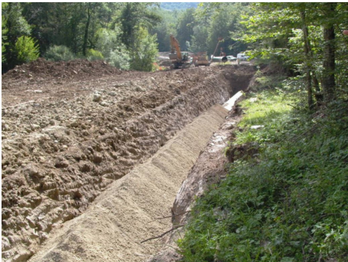
Foto 5.1.10/A - Rinterro della condotta
