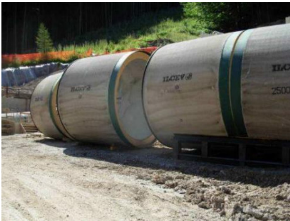
Foto 5.1.12/E - Stoccaggio tubi in c.a
