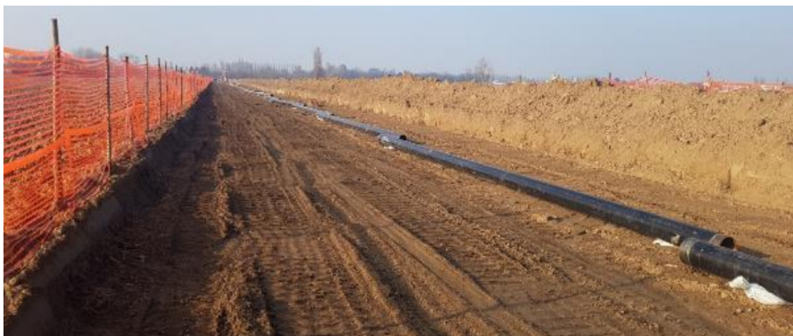
Foto 5.1.4/A – Sfilamento delle tubazioni di linea
