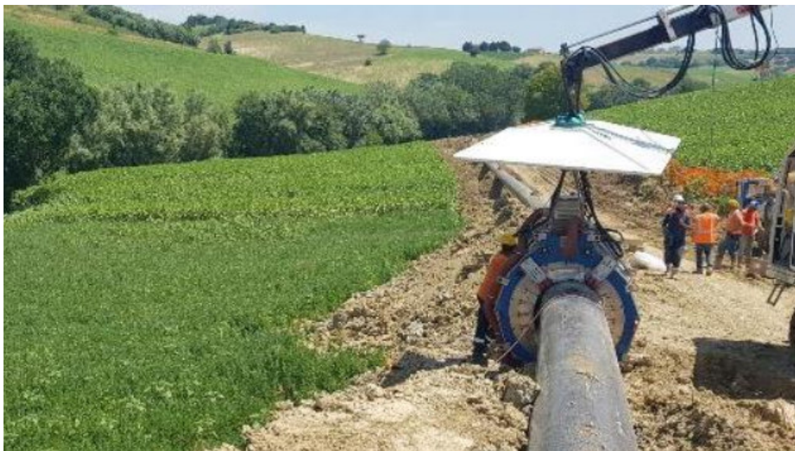
Foto 5.1.5/B - Saldatura automatica
