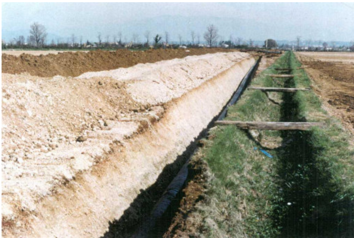
Foto 5.1.9/B - Tratto di condotta posata, con accantonamento dello strato humico separato dal materiale di scavo della trincea
