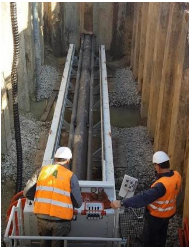
Foto 5.1.11/A - Trivellazione con spingitubo
