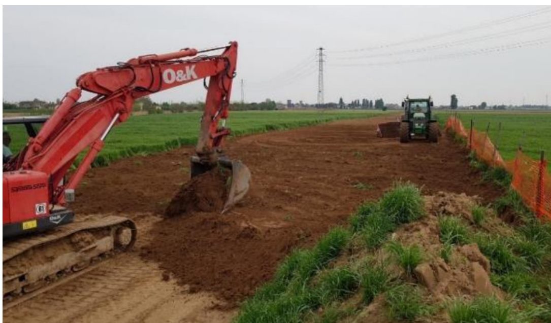
Foto 5.1.10/B - Distribuzione dello strato humico superficiale
