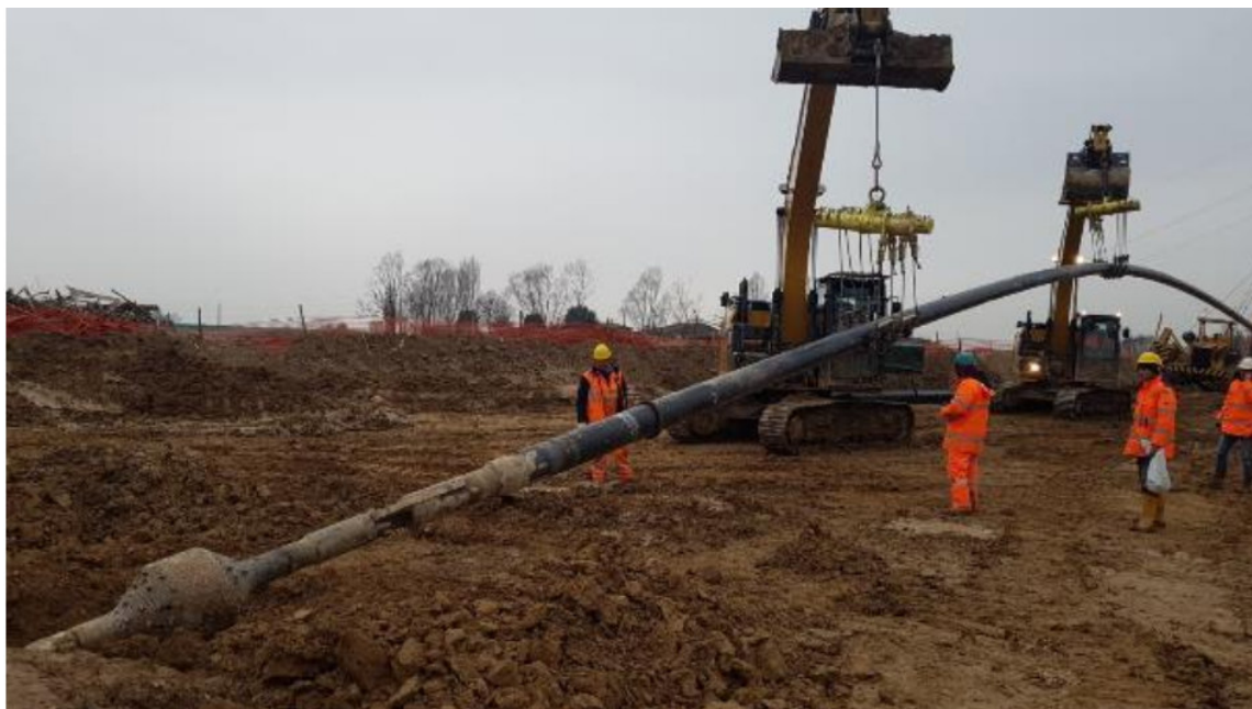
Foto 5.1.12/B - Operazione di varo della TOC
