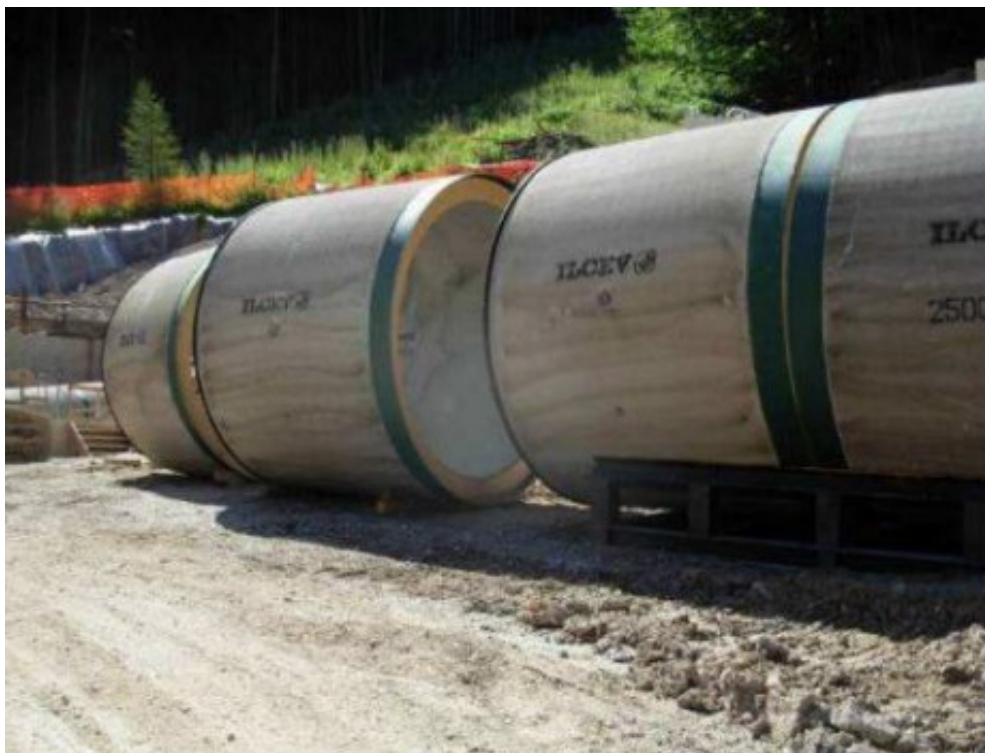
Foto 5.1.12/E - Stoccaggio tubi in c.a
