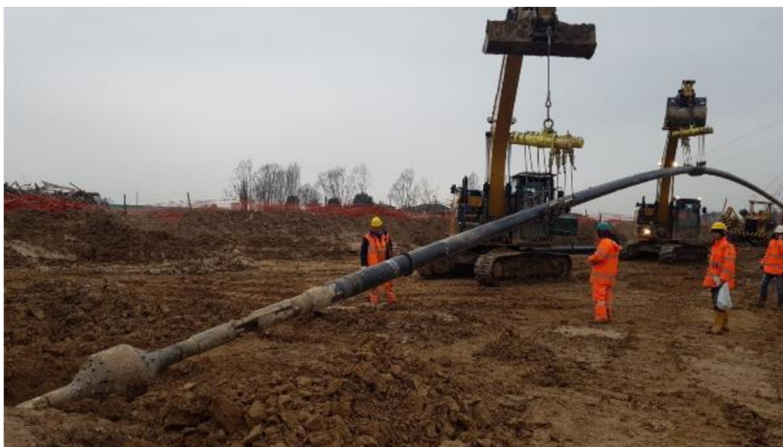
Foto 5.1.12/B - Operazione di varo della TOC
