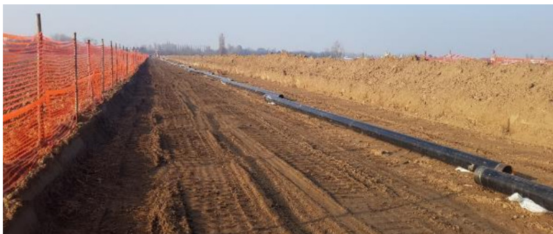
Foto 5.1.4/A – Sfilamento delle tubazioni di linea
