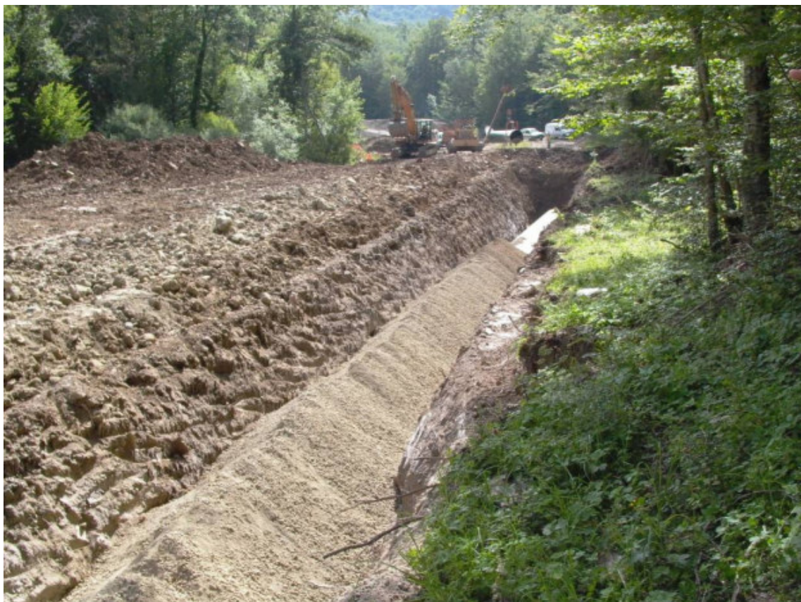
Foto 5.1.10/A - Rinterro della condotta
