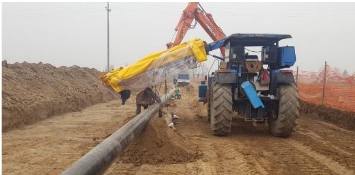
Foto 5.1.5/A - Saldatura manuale
