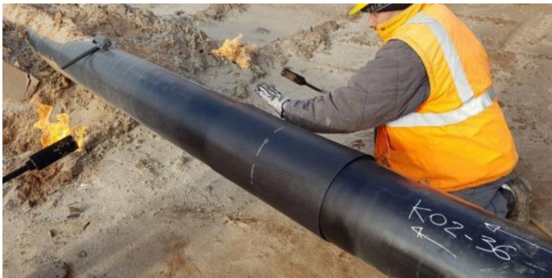
Foto 5.1.8/A - Applicazione manuale di una fascia termorestringente su giunto di saldatura
