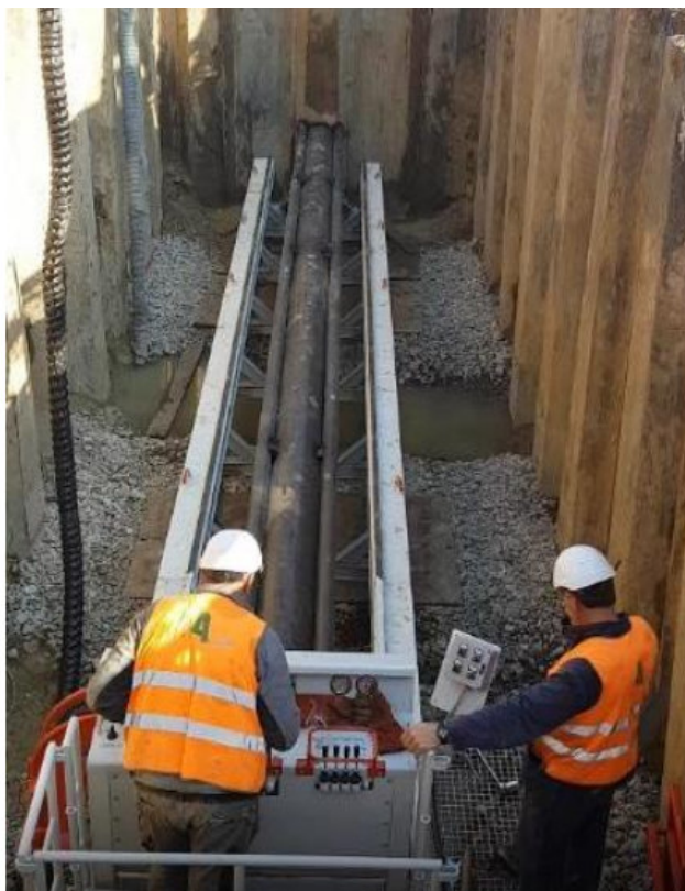
Foto 5.1.11/A - Trivellazione con spingitubo
