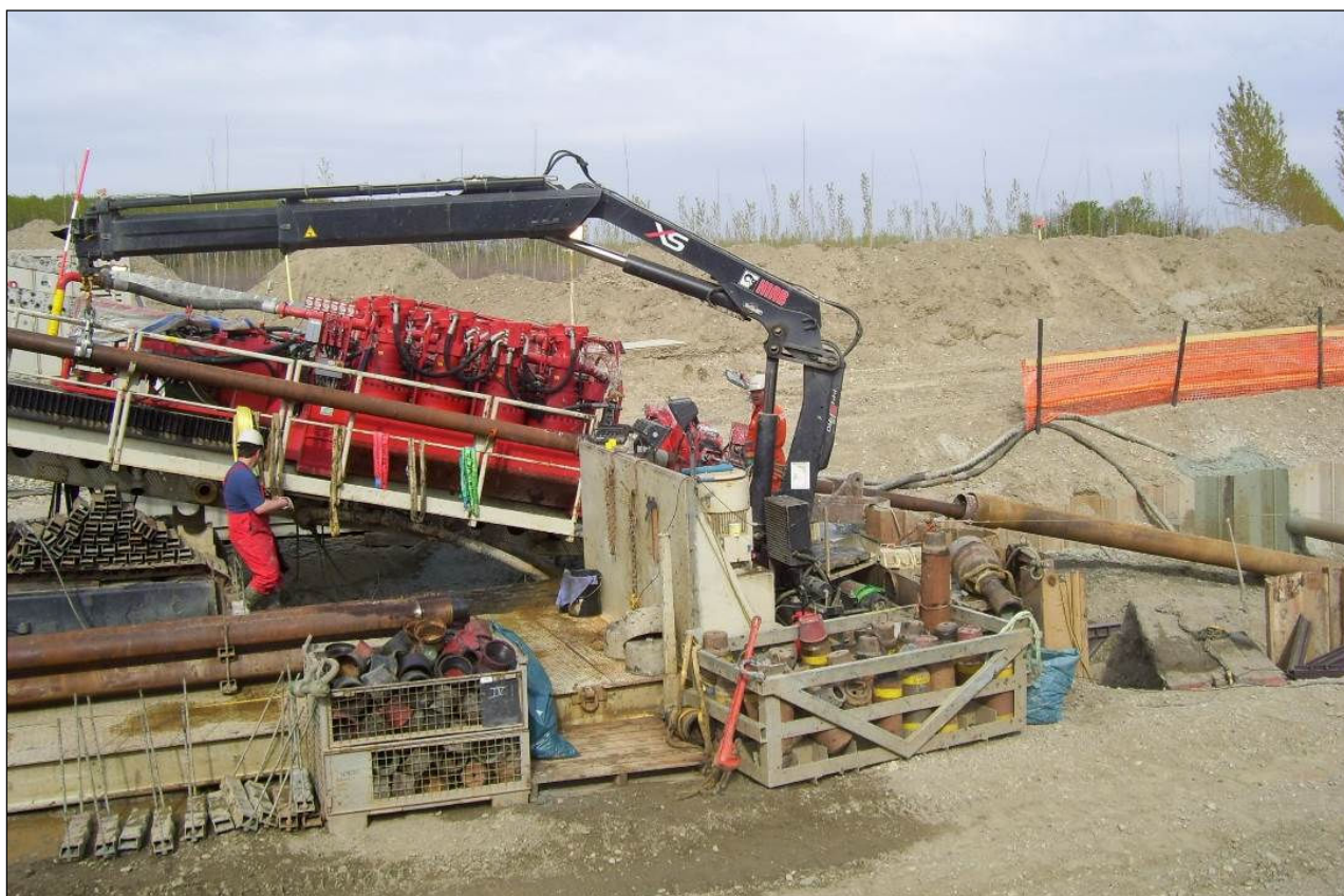
Fig. 5.2 – Rappresentazione fotografica esemplificativa postazione "Rig" per realizzazione foro pilota
