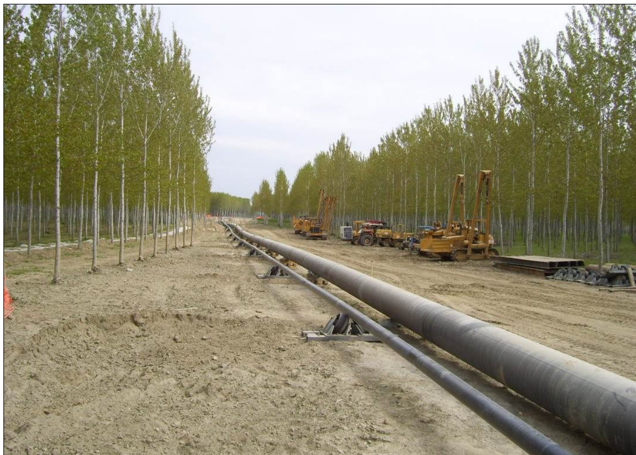
Fig. 5.4 – Rappresentazione fotografica esemplificativa – tubazione pre-assemblata su pista di varo
