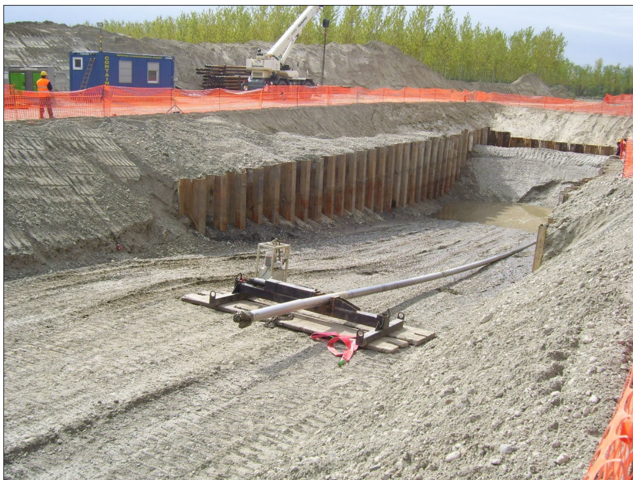
Fig. 5.3 – Rappresentazione fotografica esemplificativa – fase di uscita dell'asta pilota
