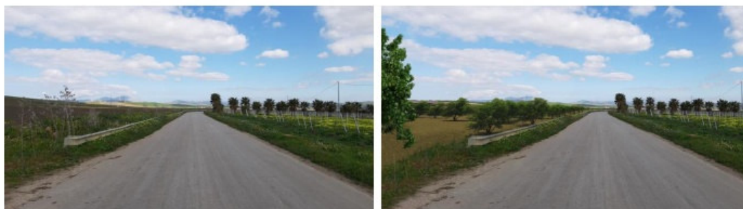
Figura 10 – Ante e Post Operam – Vista dalla Strada Provinciale che costeggia il campo a Sud.
