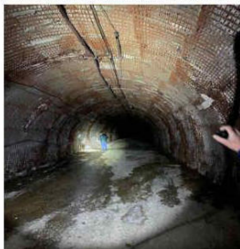
Figura 8. Particolare della pavimentazione presente in galleria.
