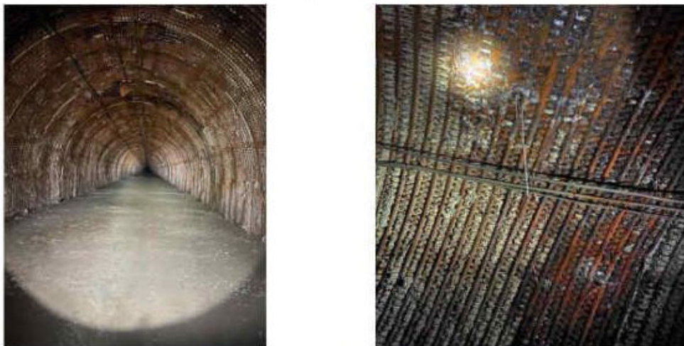
Figura 7. Caratteristiche del rivestimento interno della galleria.
