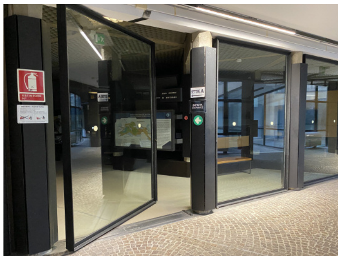
INGRESSO SETTORE B
