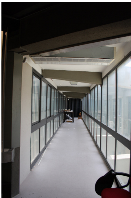
TUNNEL COLLEGAMENTO SETTORE
